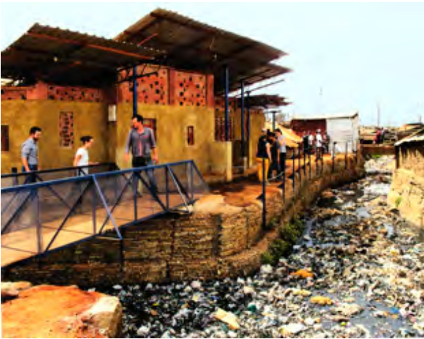
Mithilfe der Bewohner: Mehrzweckgebäude in Kibera
