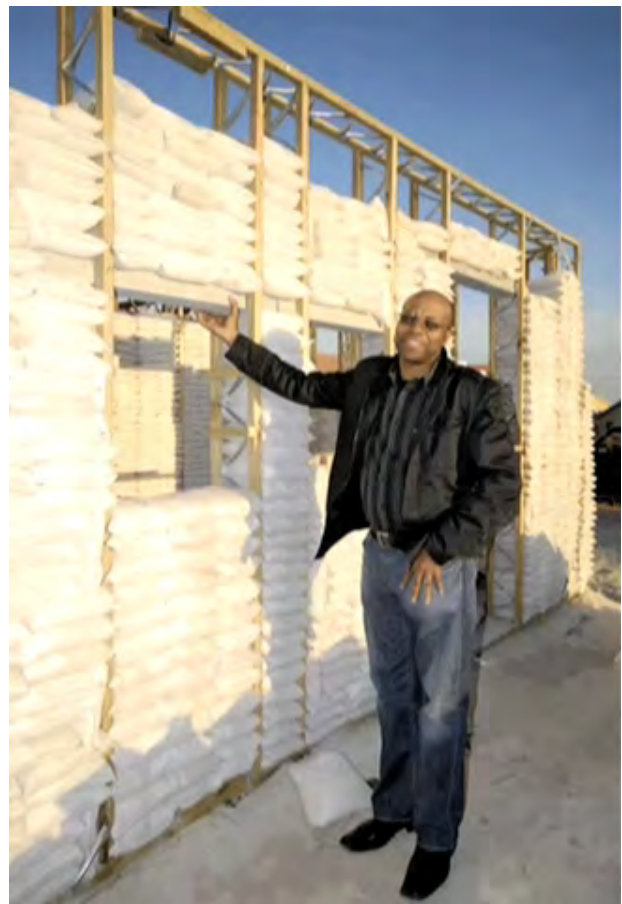
Billig und gut: Sandsack-Wand, Architekt Mpahlwa
