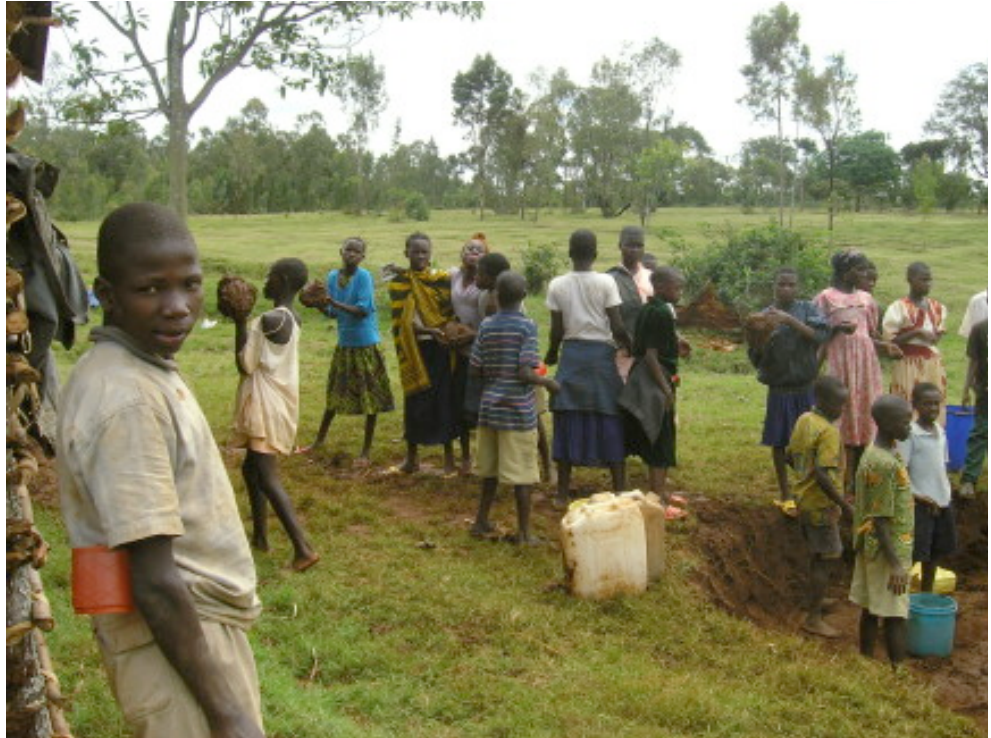
Viel lachen, viel arbeiten: VSI-Mitglieder in Itongo bauen ein Lehmhaus
