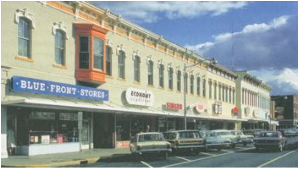
Renovierte Fassaden in Columbus: Erker in orange
